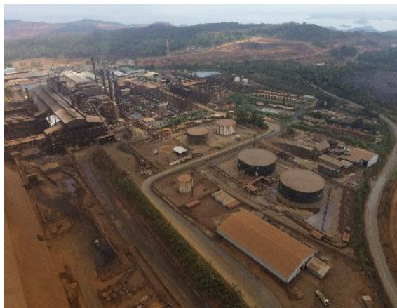
ニッケルマット製造設備（2022年10月/WALHI 南スラウェシ）
