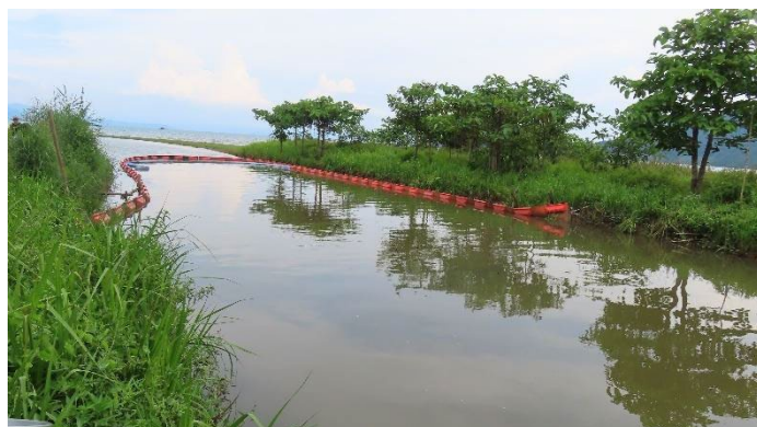
トウティ湖に流れ込む河口部に設置された重油汚染対策用トラップ（トウティ郡／2025年11月）
